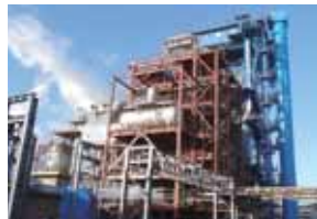
乾熄焦餘熱發電 (節能環保行業)
