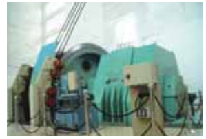
大型礦井提升機 (煤礦)
